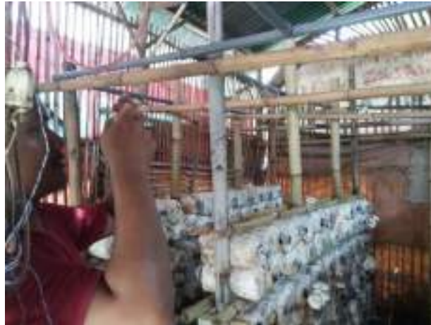
Gambar 7. Pemasangan pipa dan saluran air
