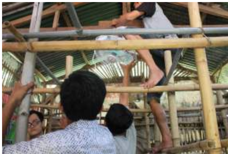
Gambar 10. Pemasangan kipas angin pada kumbang
