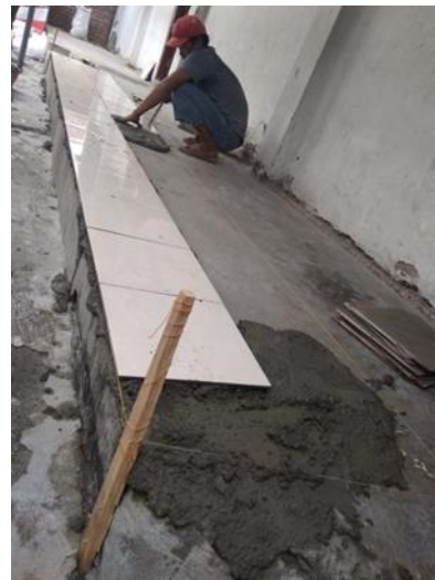
Gambar 2. Pemasangan Keramik Bagian Dalam Dan Luar Ruang Balai RT
