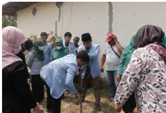
Gambar 5. Pembuatan lubang menggunakan bor tanah
