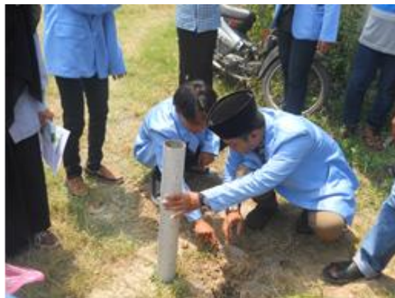
Gambar 6. Memasukkan pipa pralon ke dalam lubang yang sudah dibuat
