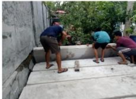
Gambar 8. Memasang penutup saluran drainase
