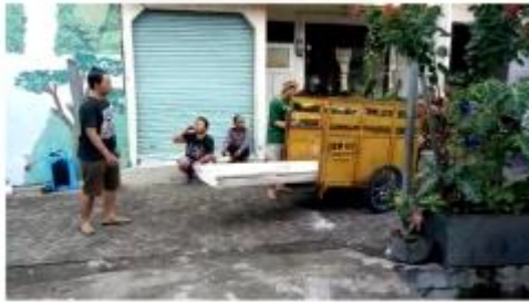
Gambar 6. Memasang penampang atas drainase
