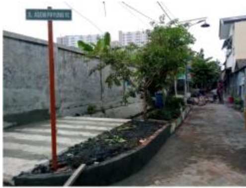
Gambar 10. Merapikan bagian tepi penutup drainase
