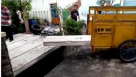
Gambar 7. Meratakan penampang atas dari drainase
